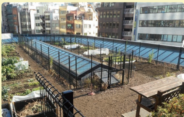
三井住友海上火災保険(株)の屋上菜園全景
